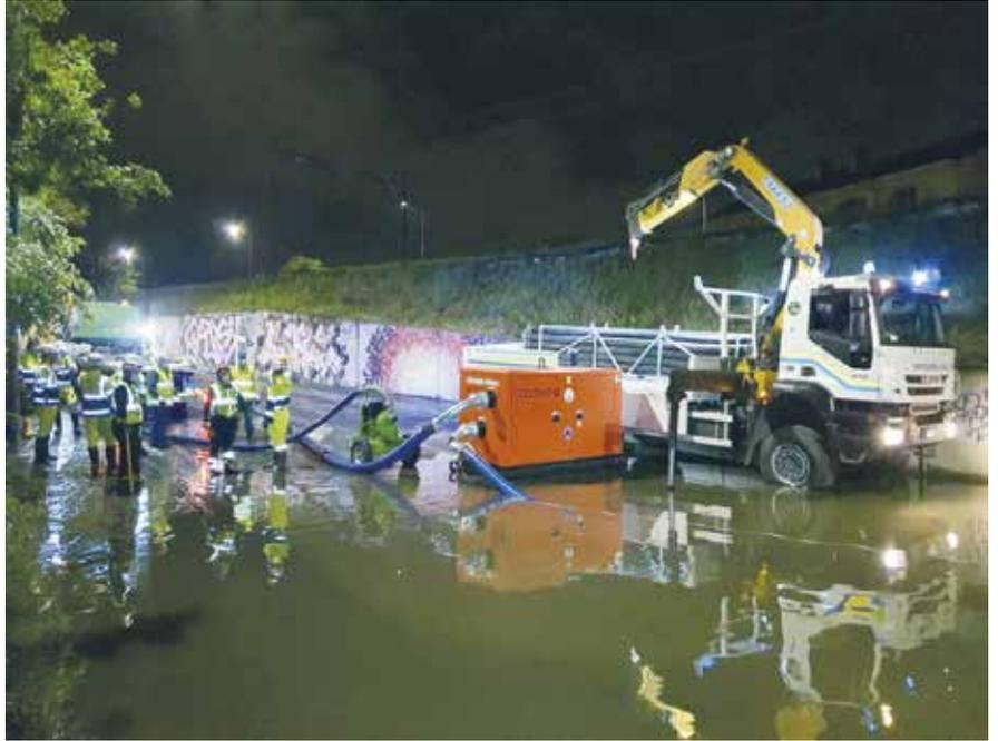
mc/h che ha permesso di pompare e far defluire velocemente l'acqua, nonostante la presenza di detriti e fango. Le operazioni sono continuate per tutta la notte e hanno visto anche dei cambi di scenario che hanno permesso di ottimizzare il posizionamento delle tubazioni di aspirazione e abbreviare i tempi di pompaggio. Il team, composto da volontari dell'Ana e della Co-
