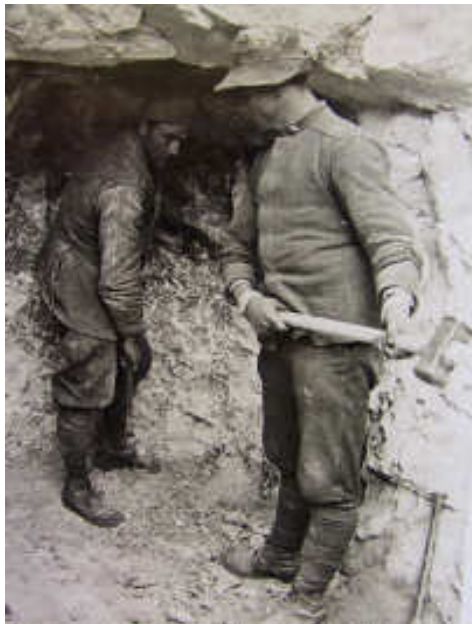
3 Alpini minatori impegnati nello scavo di una caverna. Olio di gomito, mazza e picco erano i soli mezzi a disposizione prima dell'arrivo di piccole trivelle meccaniche e di rumorosi e fragili compressori.
