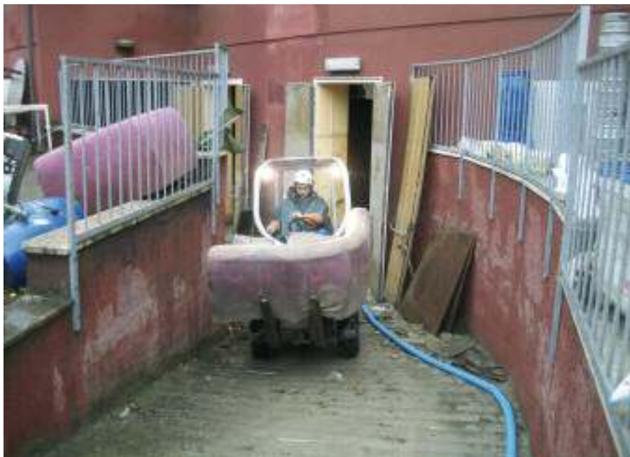
Un volontario sgombera i materiali danneggiati dall'alluvione in Emilia.
