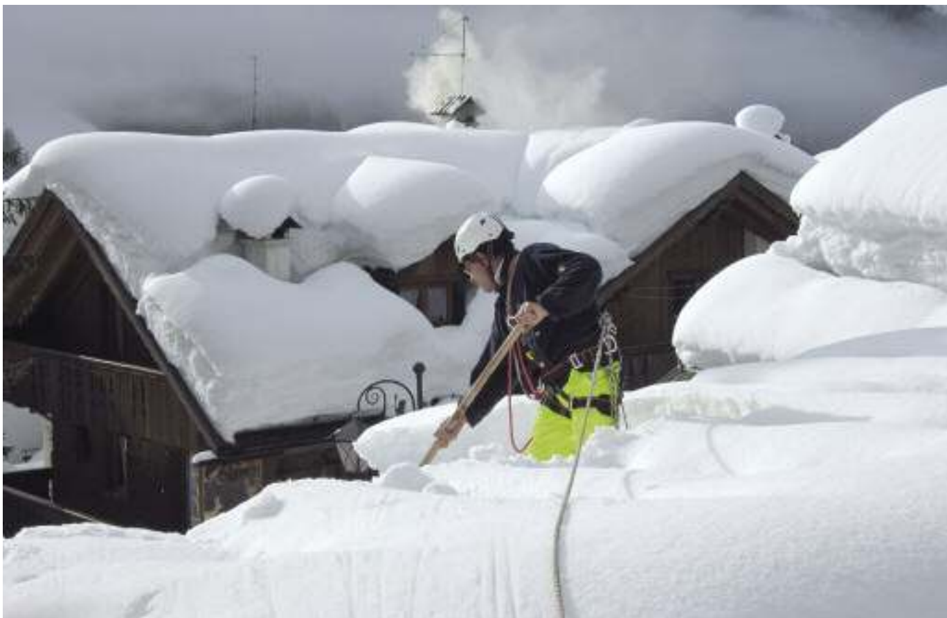
Uno specialista delle squadre alpinistiche rimuove la neve da un tetto.
