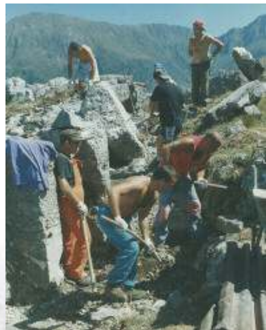
Alpini al lavoro per sistemare la trincea scudata nord.
