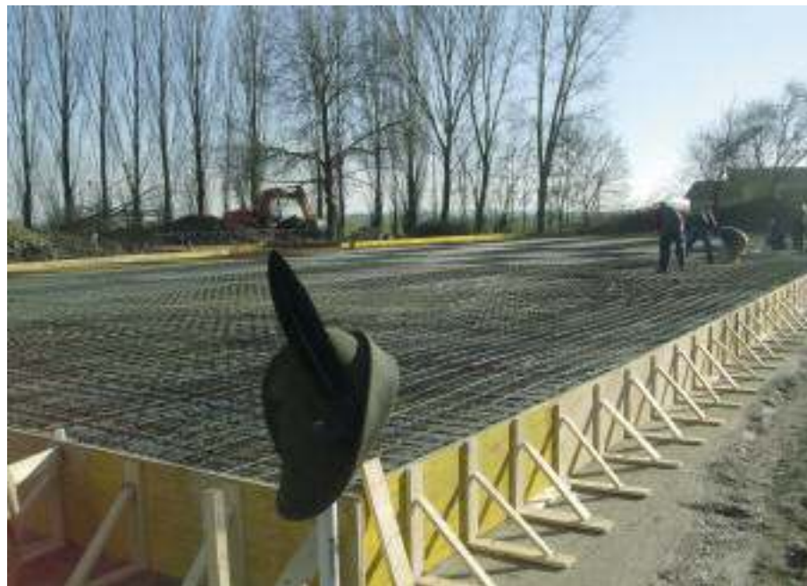
Le operazioni di armatura della platea.
