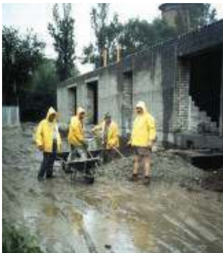
L'inizio dei lavori e l'asilo quasi ultimato.
