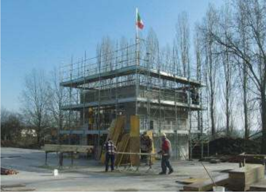
La scuola materna cresce piano... e sull'impalcatura spunta il Tricolore.
