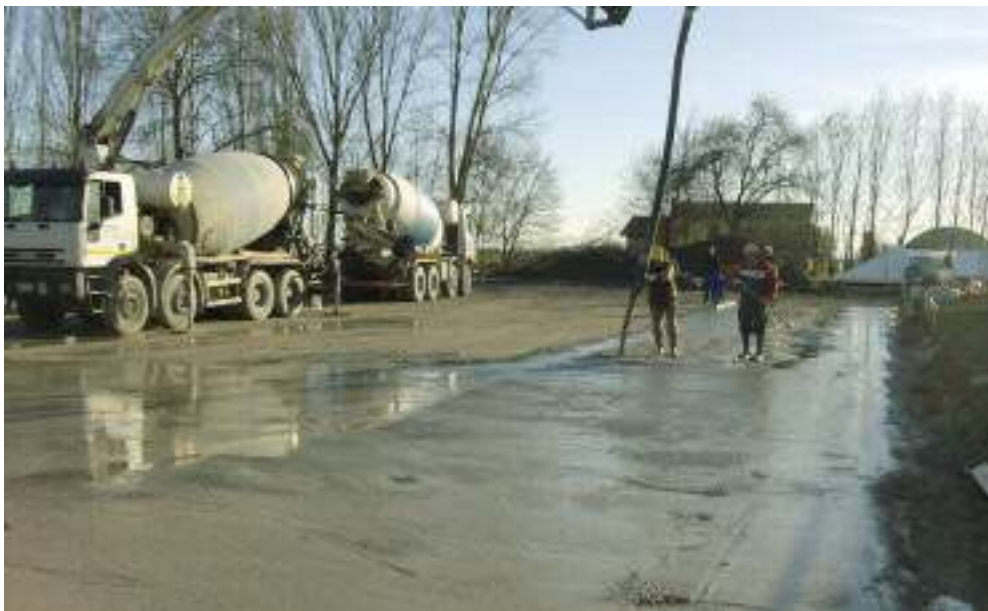
Gli alpini al lavoro per creare la platea sulla quale sorgerà la scuola materna.
