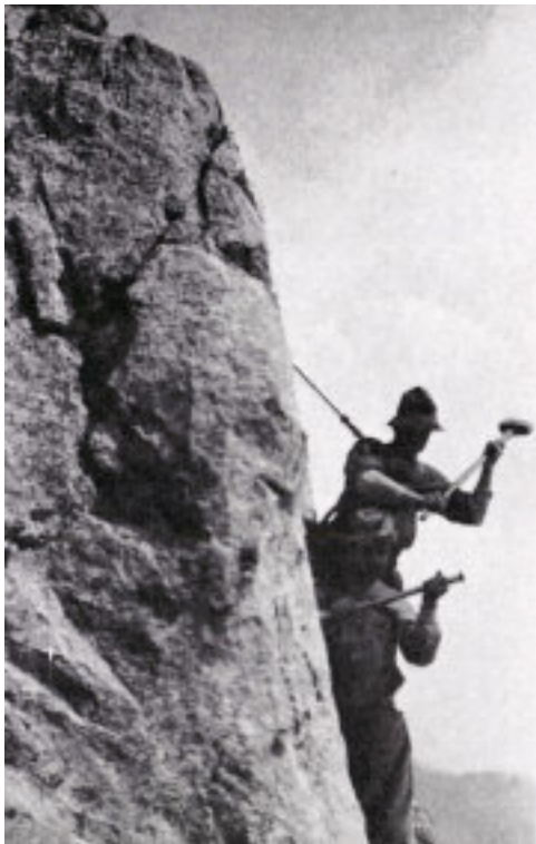
Alpini minatori alla costruzione di un camminamento in Carnia.
