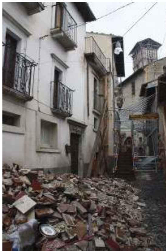
Macerie tra i viottoli del vecchio borgo di Fossa, sullo sfondo svetta il campanile lesionato della parrocchiale.
