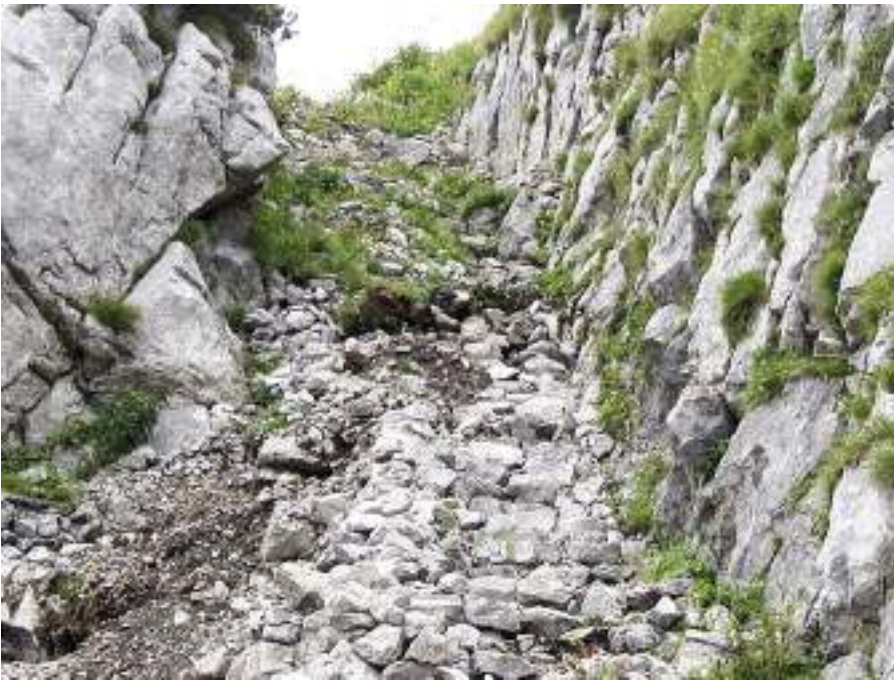
La scala prima dell'inizio lavori, durante e al termine dell'intervento.
