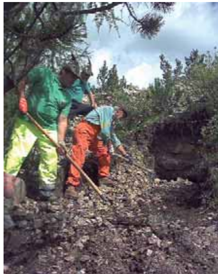
Il recupero di un bunker.
