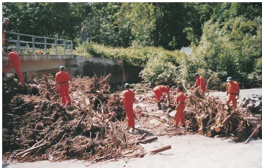
Il Nucleo di Protezione civile all'opera in Val Varaita, durante l'alluvione dell'ottobre 2000.
