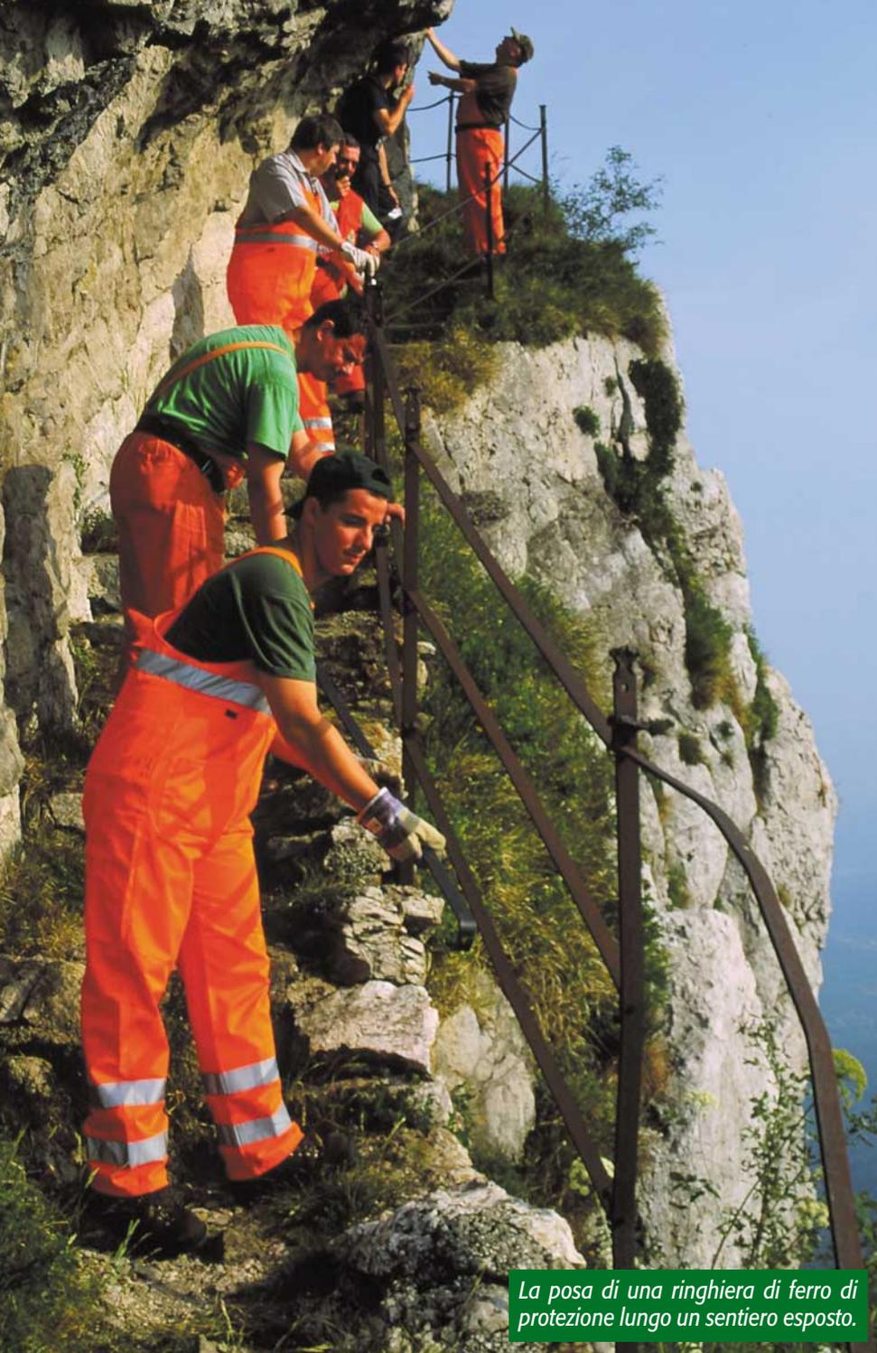
*La posa di una ringhiera di ferro di protezione lungo un sentiero esposto.*
