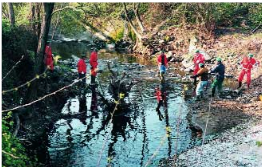
La bonifica del greto del torrente Dordo: uno dei tanti interventi a protezione del territorio alpino.
