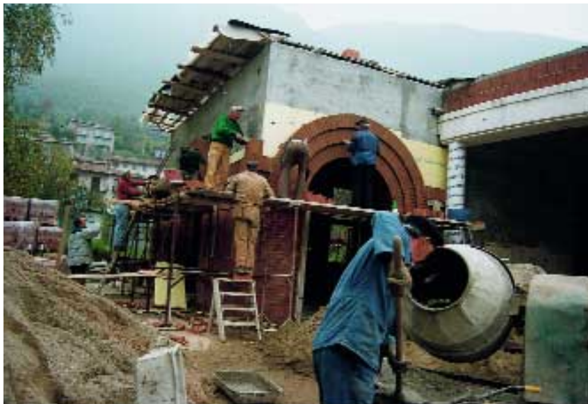
Il laboratorio per disabili di Endine Gaiano in costruzione.
