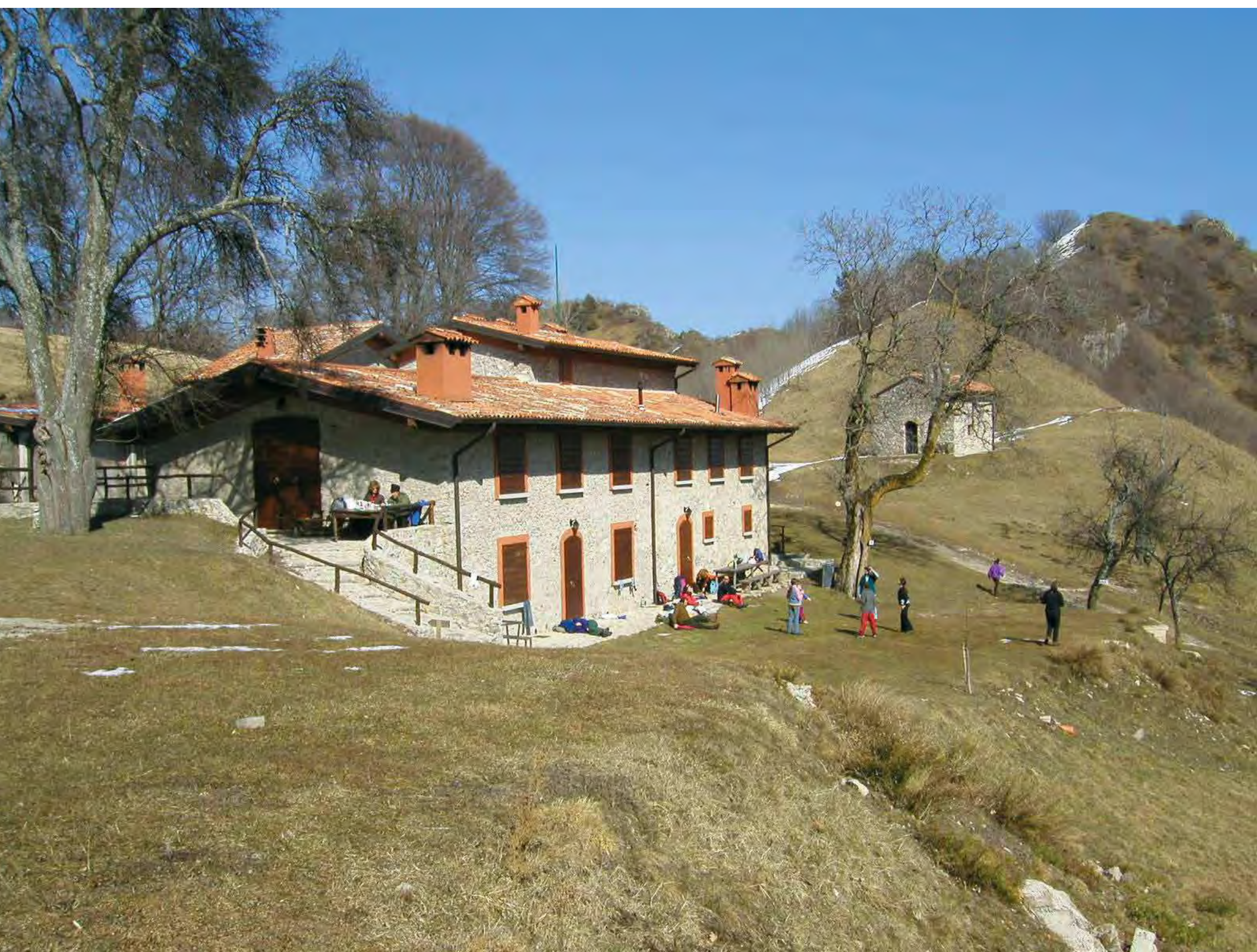
Rifugio “Giuseppe Granata” di Campèi de Sîma, sistemato dagli alpini della Sezione di Salò. Più che di un rifugio si tratta di un vero e proprio borgo alpino, composto da tre fabbricati e da una chiesetta intitolata alla Madonna della Neve
