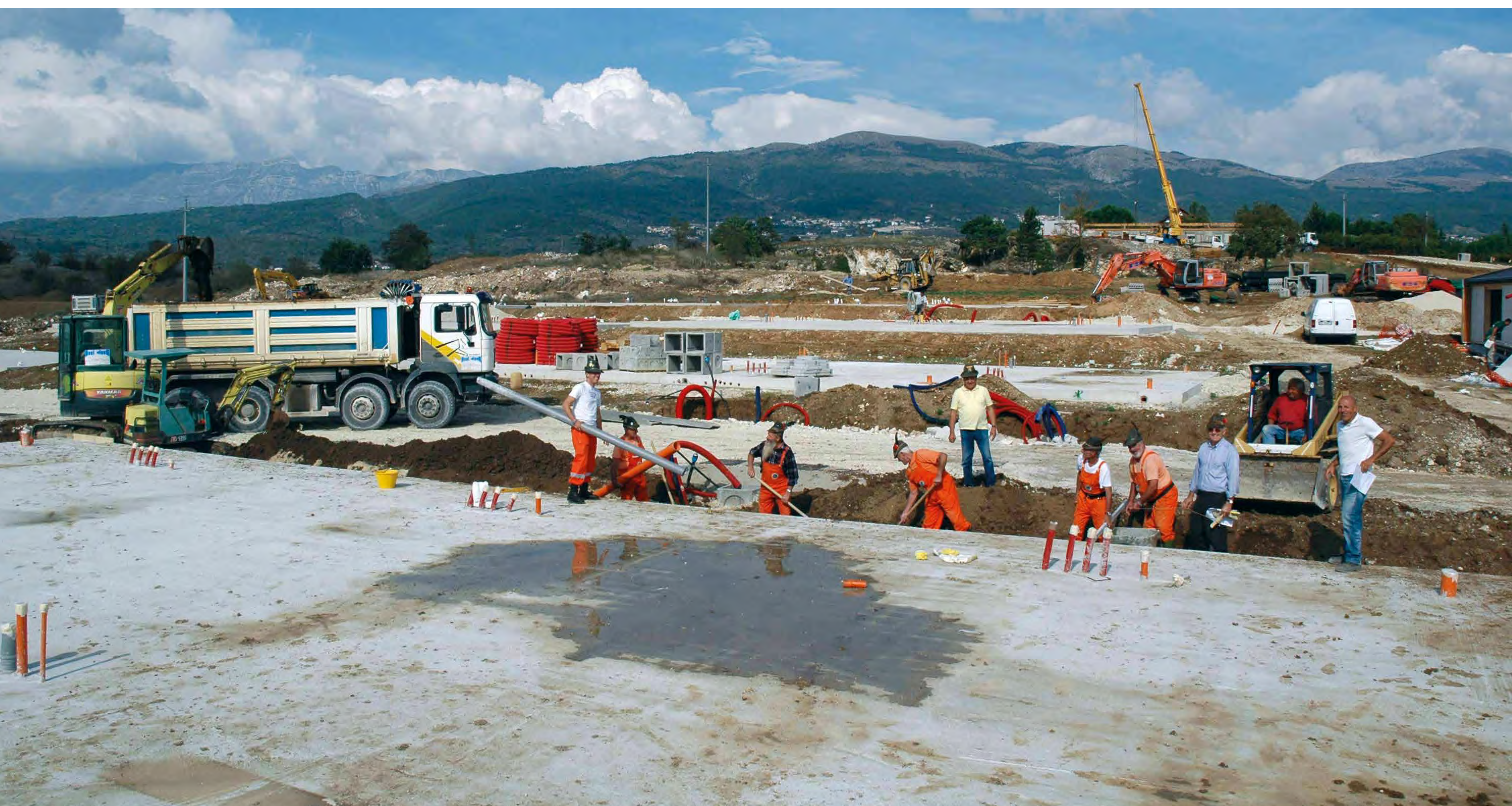
Alpini impegnati nella costruzione del villaggio a Fossa
