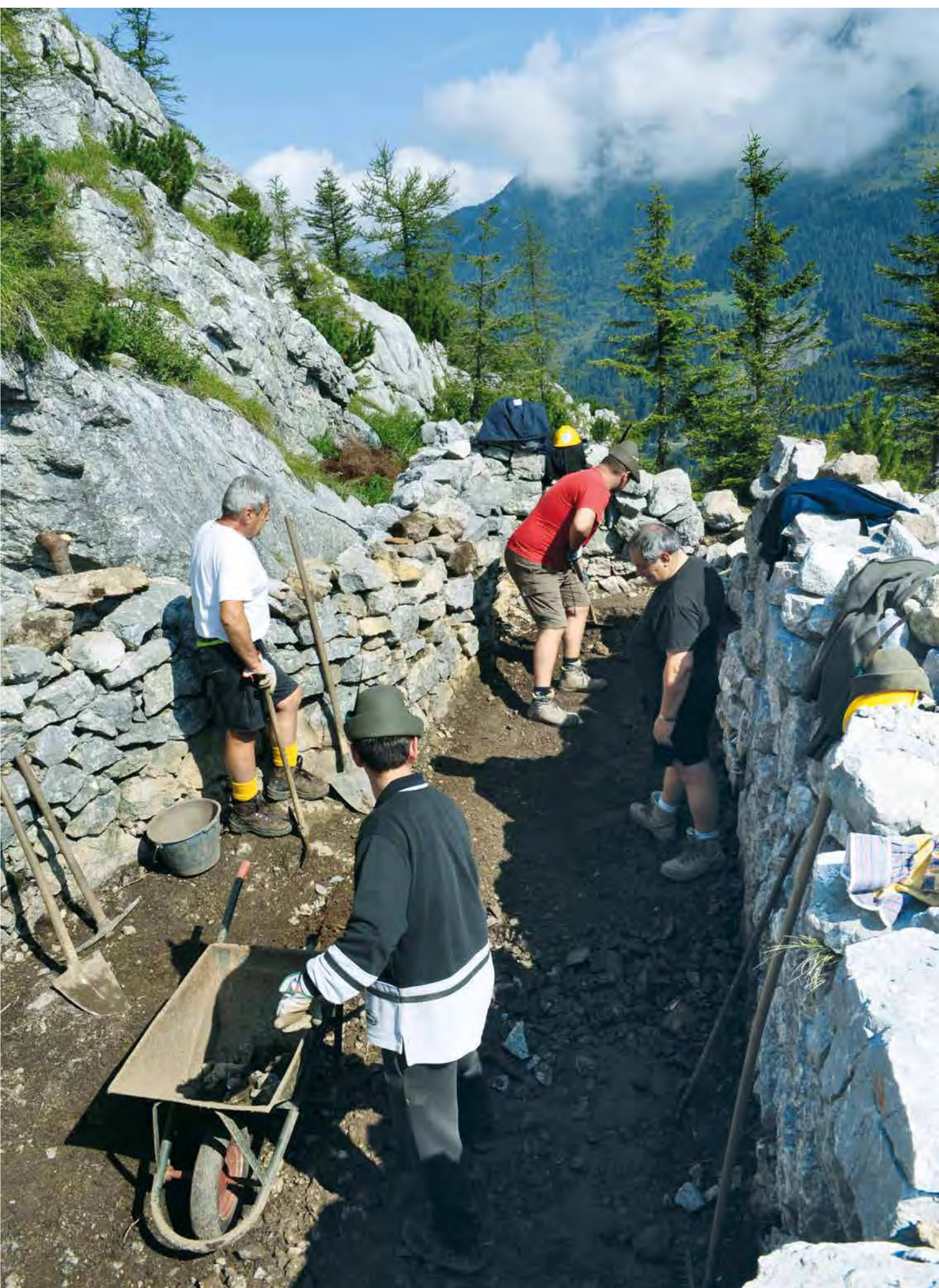
Lavori di ripristino sul Freikofel
