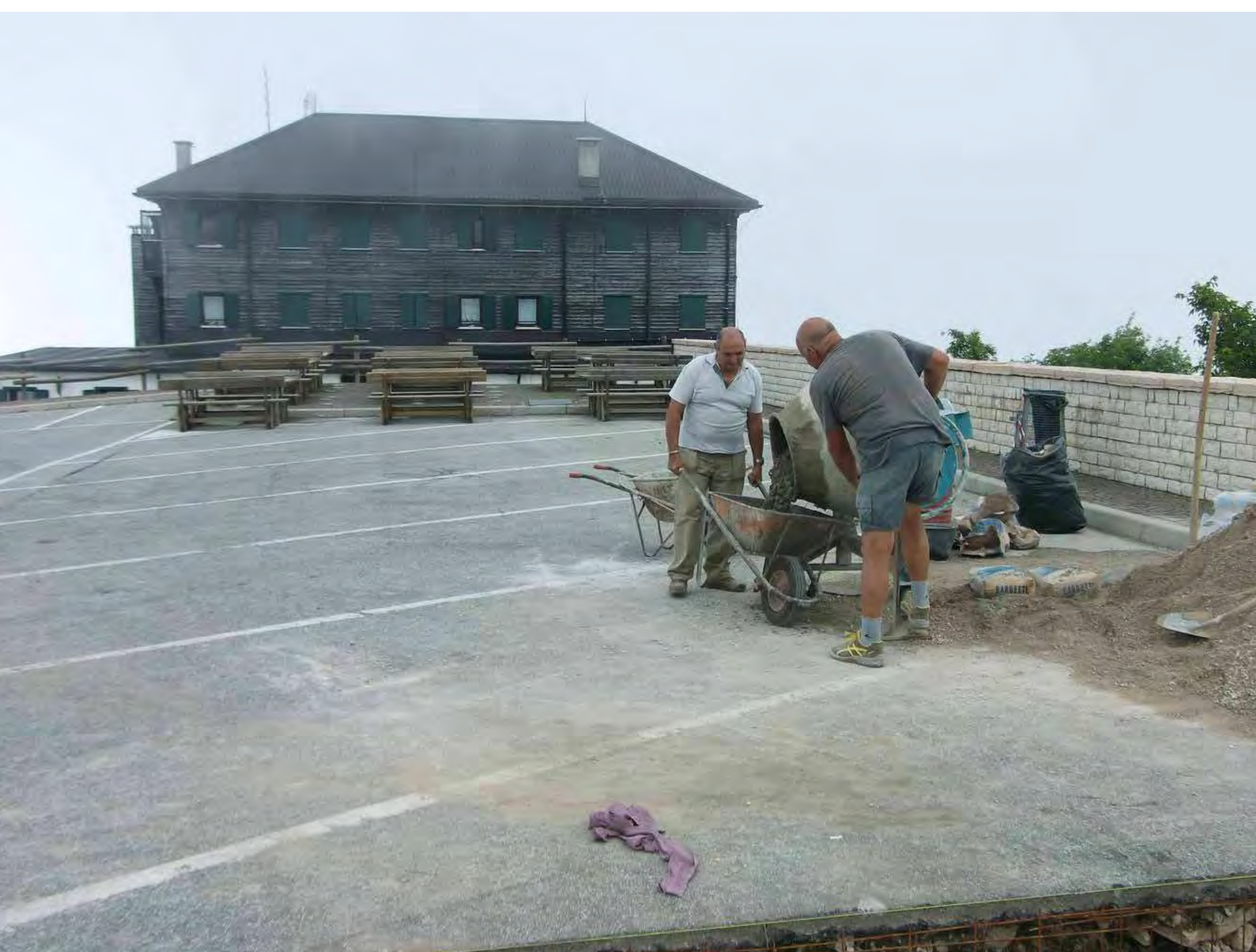
Lavori di ripristino a Cima Grappa
