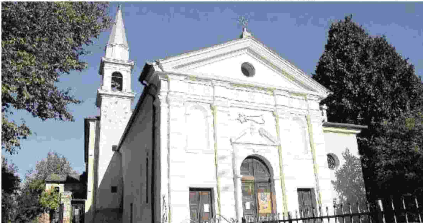
LA CHIESA La parrocchiale di San Biagio, dove dopo una decina d'anni è stato ripristinato il suono delle campane
